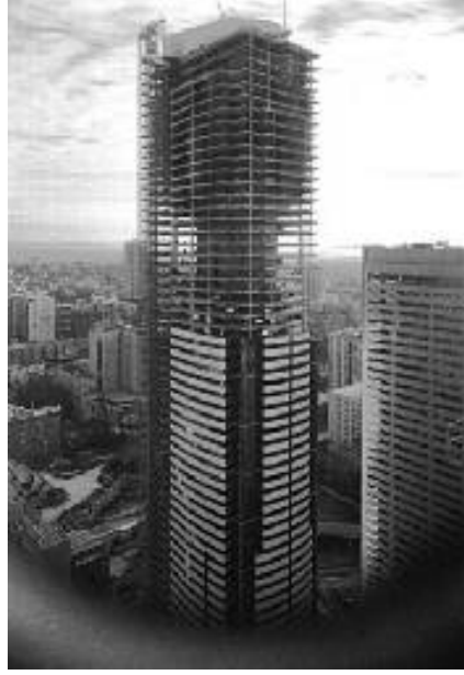
برج Two Union Square أثناء عمليات البناء
