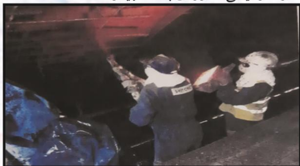
شیوه‌ی (۳-۲۰) روونکردنه‌وه‌ی به‌کارهێنانی کونکریټی هاویژراو له‌یه‌کیک له‌ تونێله‌کاندا
