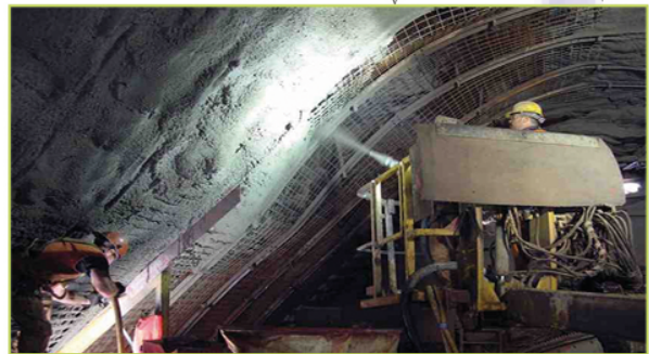
وینهي (۱۶) پرژاندي چيمه نتو (Shotcrete) به رووي ناوه ووي تونيله كه
