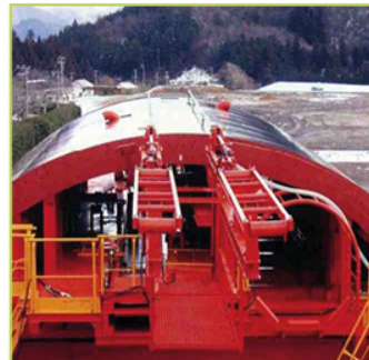
وینهی (۲۳) قوناغی ناوپوشکردنی کونکریټی (Lining Concrete)
