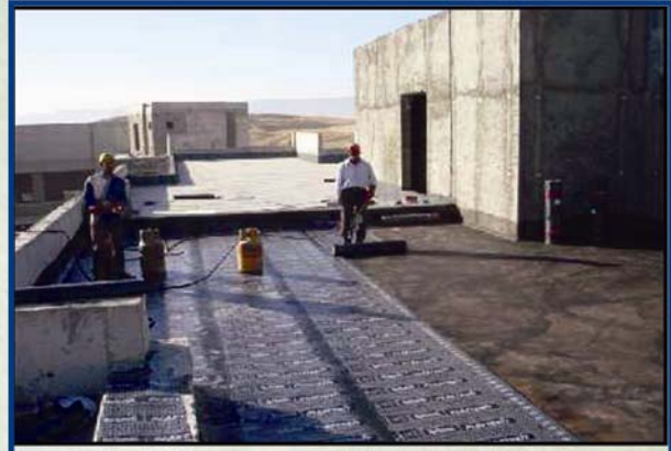
شكل (١١) : یوضح كيفية وضع طبقة اللباد القیری
