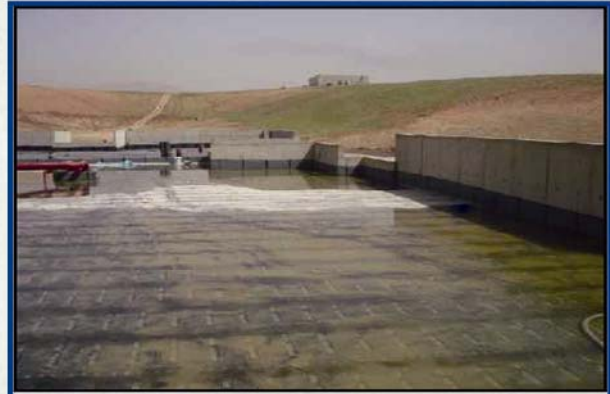
شكل (١٢) : یوضح كيفية اختبار طبقة اللباد القیری : المصدر : الباحث
