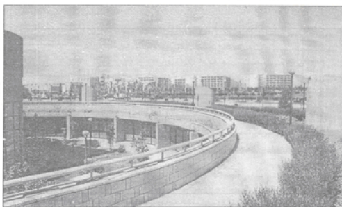
ۋىنەى 38: پەنكەر پاشەكە كە دەسەر سەكلى وەرەكەكە دىروستكراۋە ۋىنەكەرتى نە ئېرەن ئوسەرىۋە
