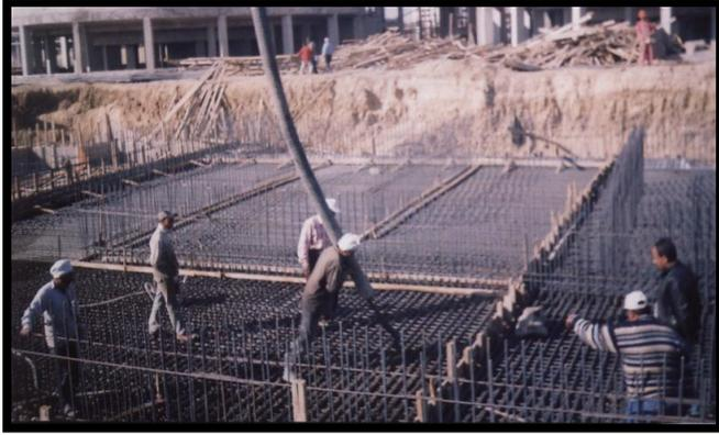
التحكم في الصب إلى أقصى درجة ممكنة حيث يمكن توجيه المواسير التي داخلها الخرسانة إلى المكان المطلوب تماماً . كما أن السرعة التي يتم بها الخلط و وصول
