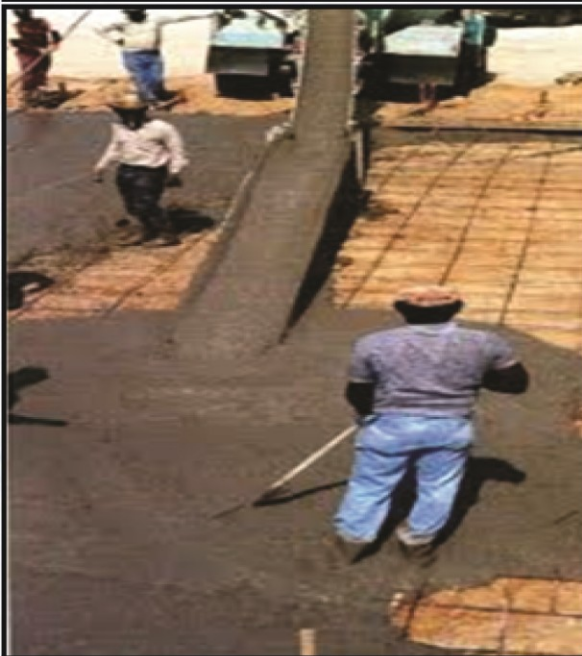
شېۋە (۹-۴) تېكرىنى كۆنكرېتىكى تۈنا بەرزى رۇ كىردن و رۇىشتن كە پېۋىستى بە بە كارھىنانى لەرلەر كەر نېە
