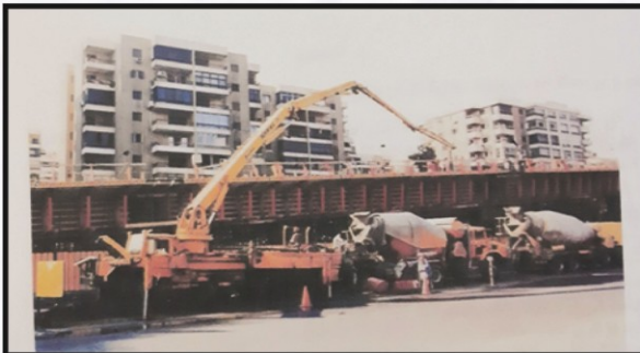
شېۋە (۵-۴) بەكارهينانى ئۆتۈمبىلى تېكەلە و گواستەۋەى كۆنكرېت و پەمبى پالئەرى لە تېكرەنى يەكك لە قۇناغە كانى پردى ۱۰ ئۆكتۈبەر
