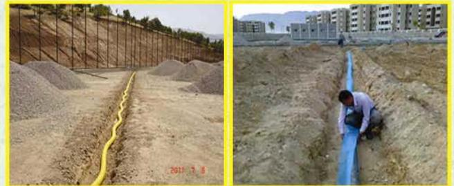
وءءا الماسورة بءبقة (ءصى) بسمءك ٢٥ سم وءاءة ءوضع طبقة نسبىءىة من Geotixtyle ءعمل ءلى إزالءة الشواءب من المىاه الزائءة فوق طبقة الءصى لءعمل ءلى منع الشواءب والمواء ءءىءة من ءءراءم ءاءل الاءابىب الصرف فءسءءها بالءءراءم
