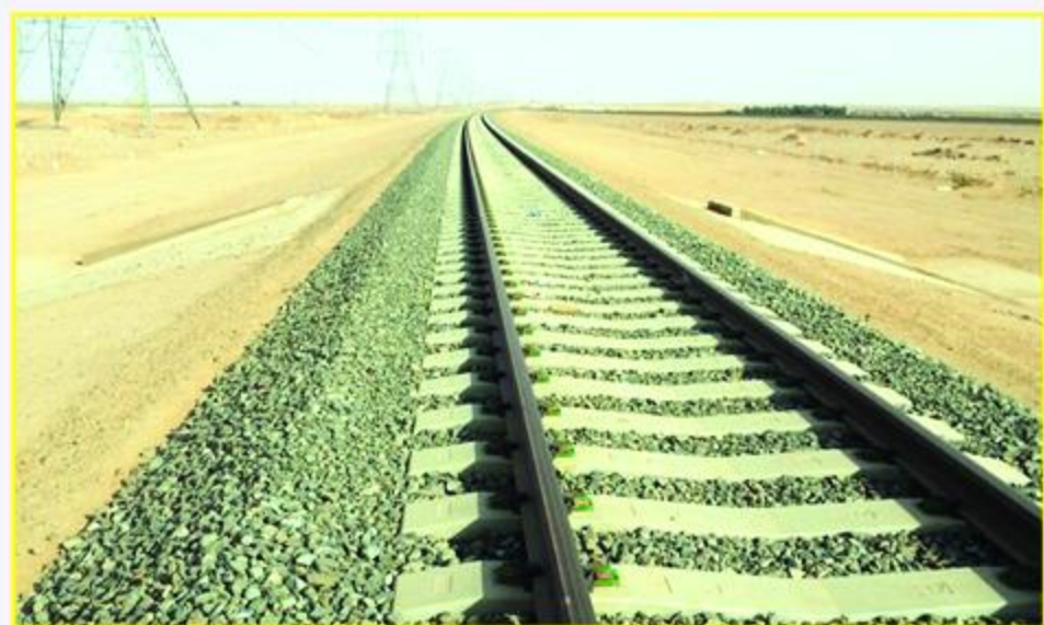
وینە ی ( ۴ ) دا کوتانی هیلە ئاسنینه له سه ره پارچه کۆنکریتی ئاماده کراو ( precast concrete )
