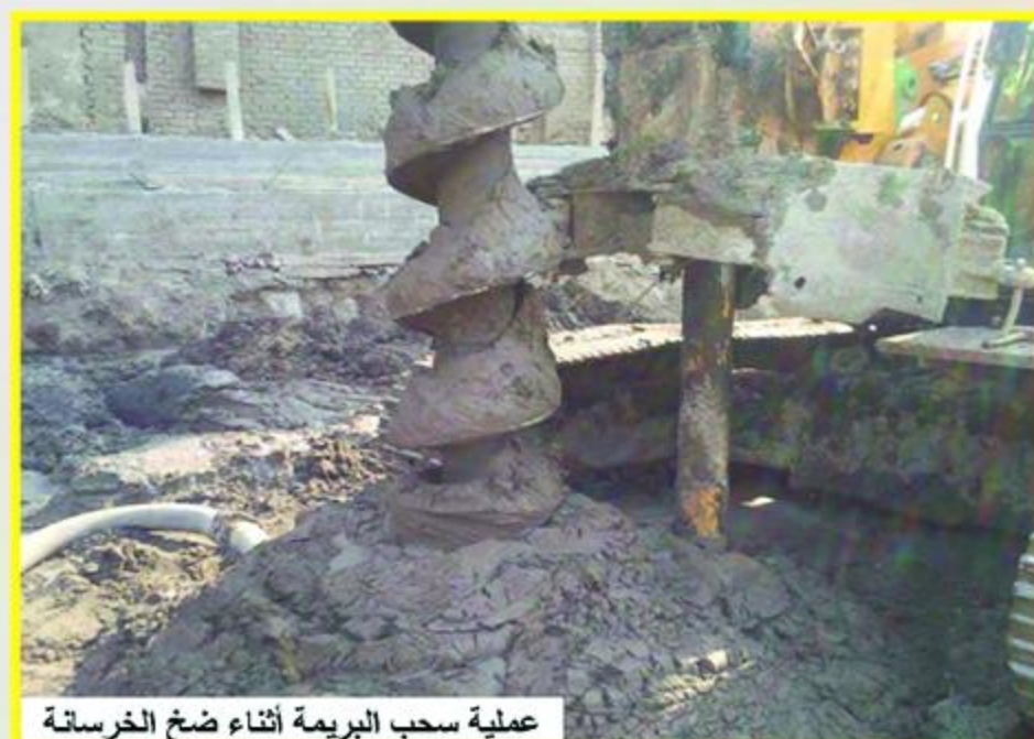
عملية ضخ الخرسانة إلى الخازوق بواسطة المضخة
