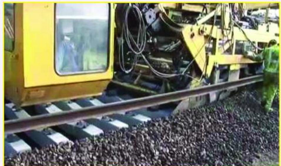
وينه ي ( ۷ ) چؤنيه تى دانانى ( Sleeper ) به ئاميرى تايهت
