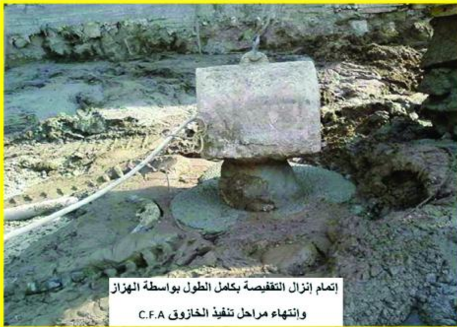
عملية إنزال التفقيصة بواسطة الهزاز
