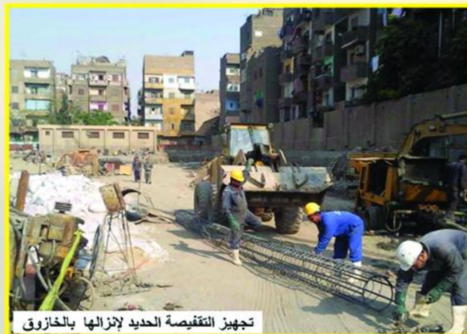
إحضار التقفيسة الحديد بواسطة اللودر
