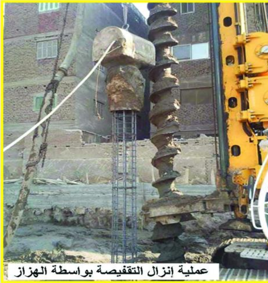
الهزاز المستخدم لإنزال التفقيصة الحديد
