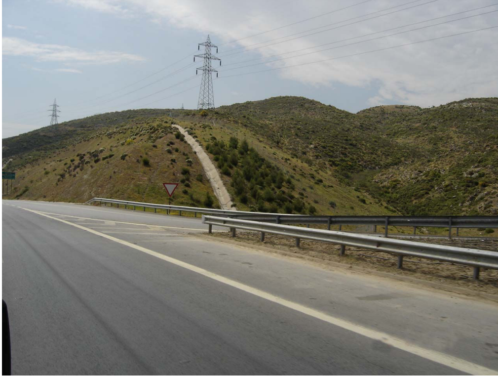
وېنەى ژمارە ( 9 ) دروست كوردنى جۇگا ( ساقىه ) بۇ پاراستنى ( Side Slope ) و كەم كوردنەوہى ئاوى جۇگە تەنىشتەكان ( Side ditch )
