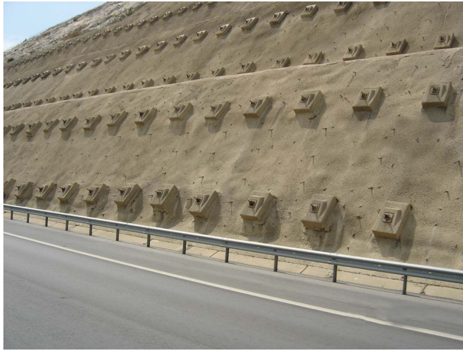
وینه‌ی ژماره ( 7 ) چونیه‌تی چاره‌سه‌رکردنی ( Side Slope ) به‌ریگه‌ی ( Crouting و BRC ) و کونکریت (
