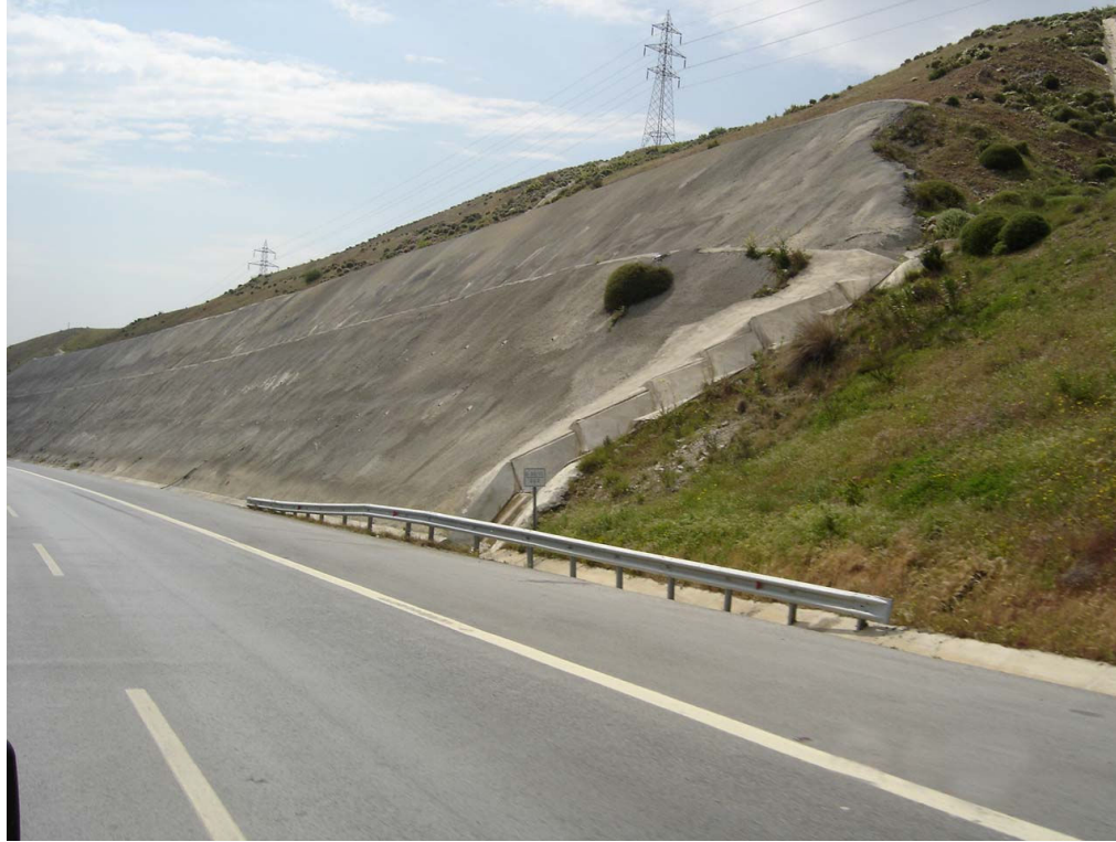
وینہی ژماره ( 8 ) چونیه تی چاره سه رکردنی ( Side Slope ) به ریگه ی داپوشینی ( Pitching ) به ( Shot Crete )
