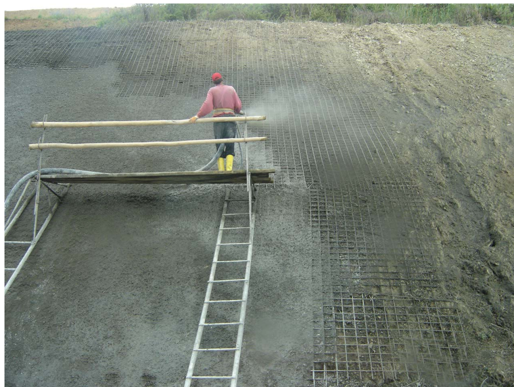
وینەى ژماره ( 6 ) چۆنیه تی چاره سه رکردنی ( Side Slope ) به رېگه ی ( Shotcrete )
